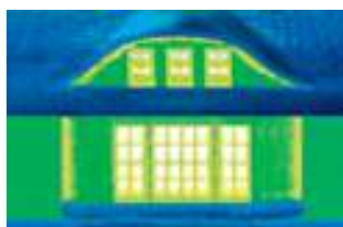
EFTER: Det ses nu tydeligt at vinduerne fjerner varmetabet
